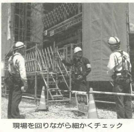
現場を回りながら細かくチェック
